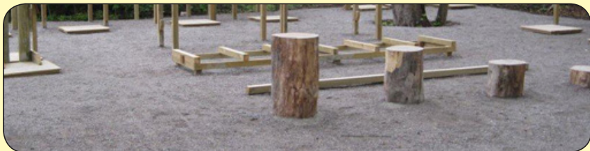
Byggstart för utegym på idrottsplatsen är planerat till maj.
